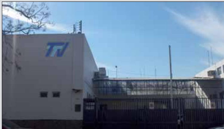
FABRICA TTV MEXICO TTV PLANT MEXICO TTV- WERK MEXIKO
